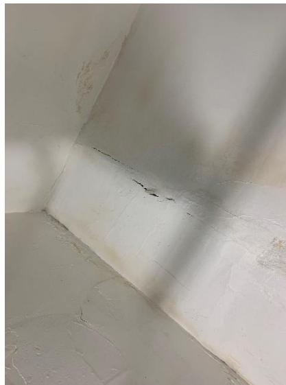
Plafond au-dessus du bain
