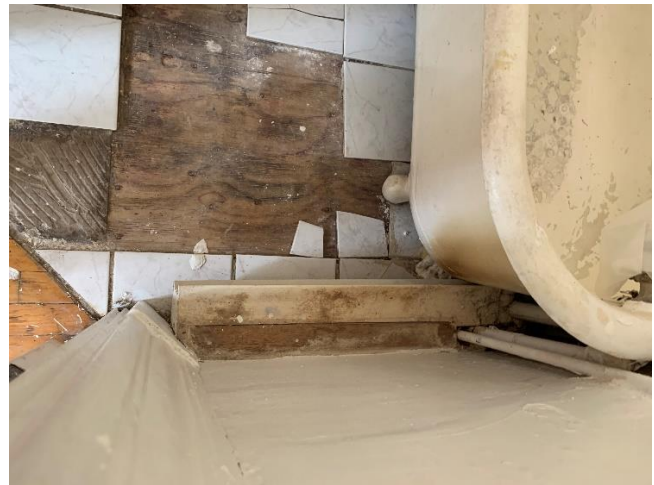
Plancher et chauffage salle de bain
